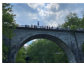
旧士幌線「音更川第5橋梁」 の見学
