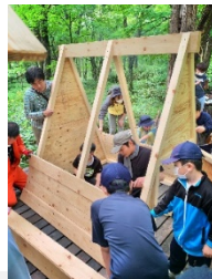
ツリーハウス組立作業状況
