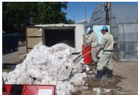
雪は雪山からコンテナ(写真)に貯蔵されて、冷熱として利用されています
